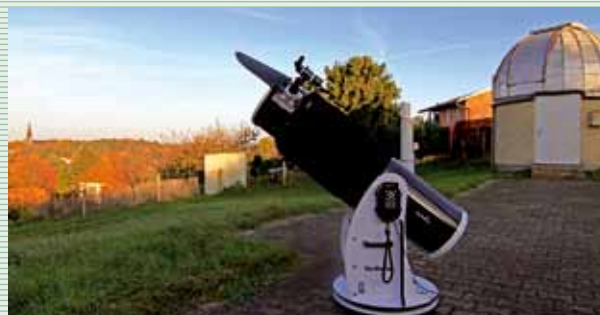
Kuppelgebäude mit fest installiertem Spiegelteleskop auf einer EQ8 - Steuerung und Teleskop Dobson
